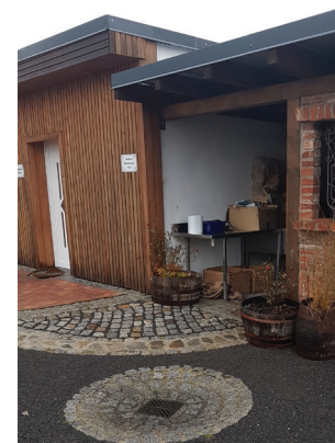
Anbau neben den WCs
